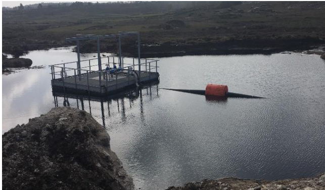
Reposição da captação de água de Lixa do Alvão
