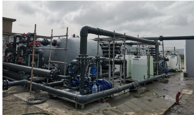
Construção da Estação de Tratamento de água de Lixa do Alvão
