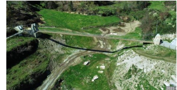
Reposição da Ponte de Arame em Santo Aleixo de Além Tâmega
