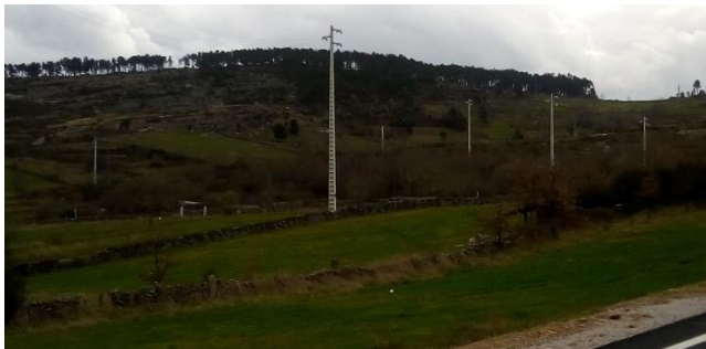
Reposição de linhas elétricas
