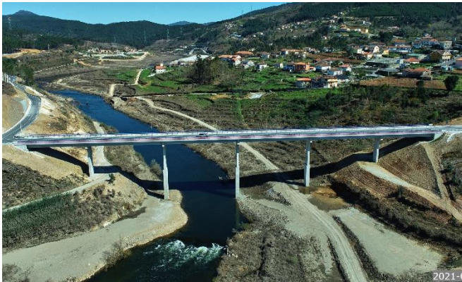
Reposição da ponte EM312
