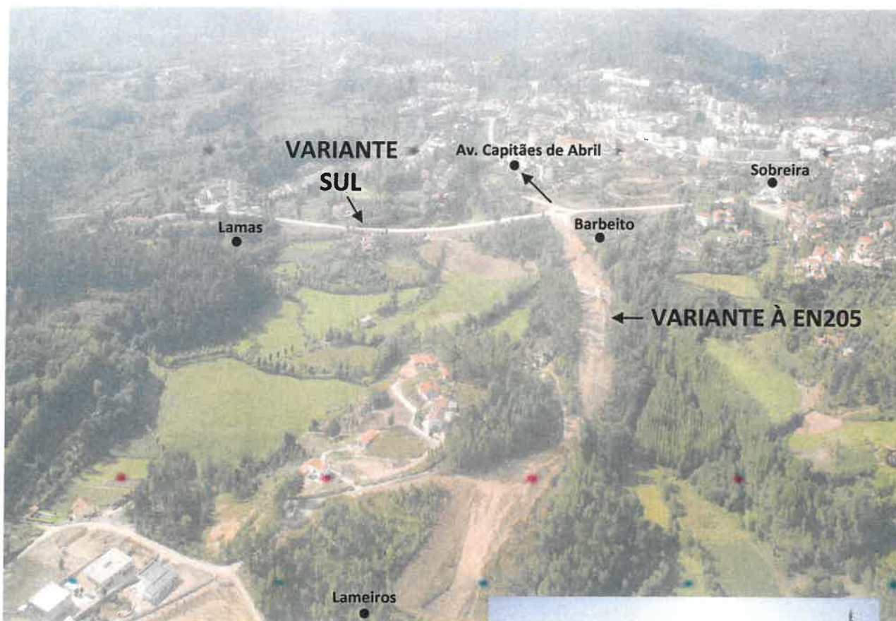
Novas Vias em Construção
