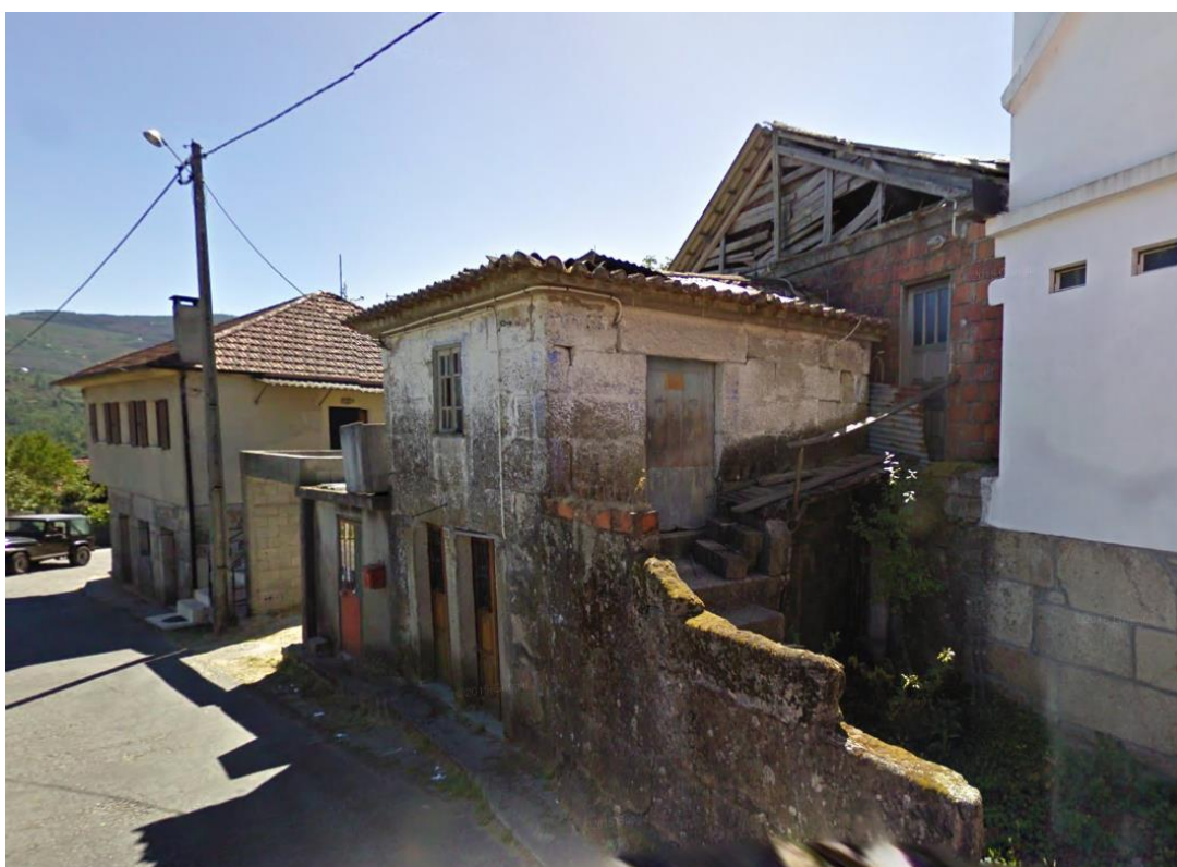
Figura 7. Edifícios em péssimo estado de conservação – Rua do Pedral
