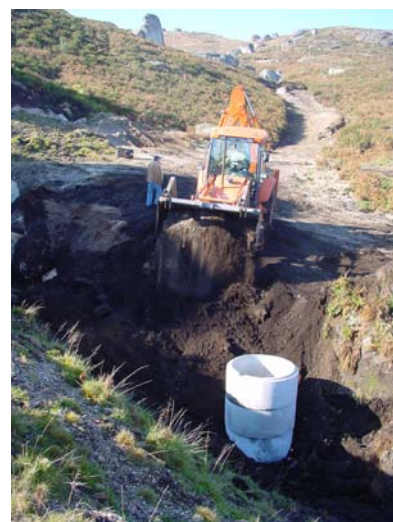
Continuação das obras de abastecimento de água ao lugar de Cucana - Refojos
