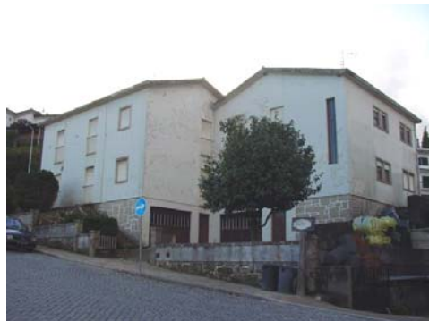
Obras de beneficiação e adaptação da antiga casa dos Magistrados (Propriedade da Câmara Municipal)
