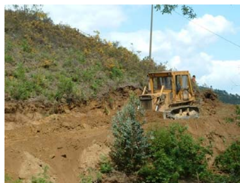
Rompimento do caminho do Bairro da Ranha – Painzela Pavimentação em alcatrão
