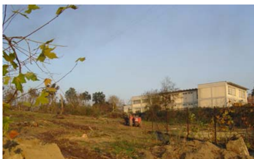
Desmatação do terreno Construção do Pavilhão Desportivo de Cavez
