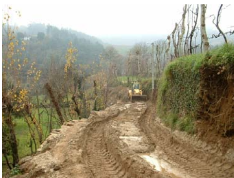
Alargamento do caminho da Bouça – Faia Pavimentação em alcatrão
