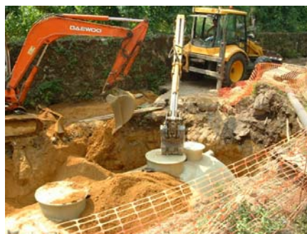
Instalação da ETAR compacta Continuação das obras de saneamento no lugar de Chacim - Refojos
