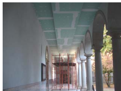
Continuação das obras de beneficiação do Edifício dos Paços do Concelho
