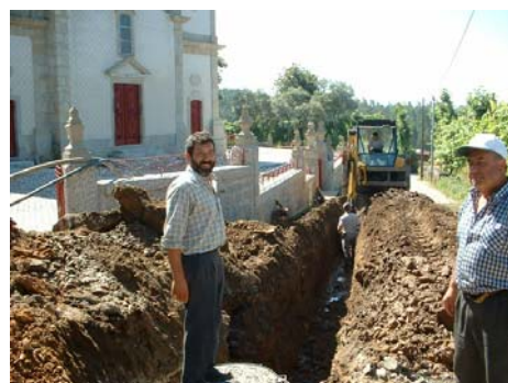
Continuação da ampliação da rede de saneamento na freguesia de Cabeceiras (S. Nicolau)
