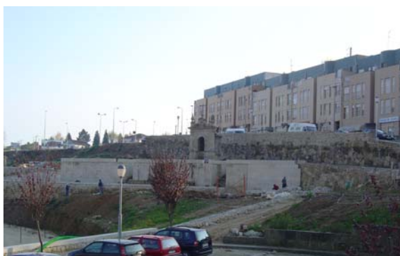
Obras de requalificação da Zona Adjacente ao Mosteiro S. Miguel de Refojos
