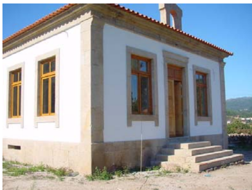
Conclusão das obras de beneficiação e recuperação da antiga Escola de Lameiros, em Refoios
