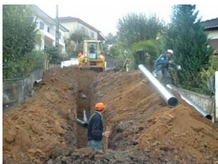
Continuação da ampliação da rede de saneamento no Bairro da Portela – Alvite
