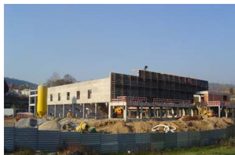
Conclusão das obras do Pavilhão Desportivo de Refojos
