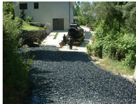
Continuação da pavimentação em alcatrão do caminho do Seixo ao Guião - Basto
