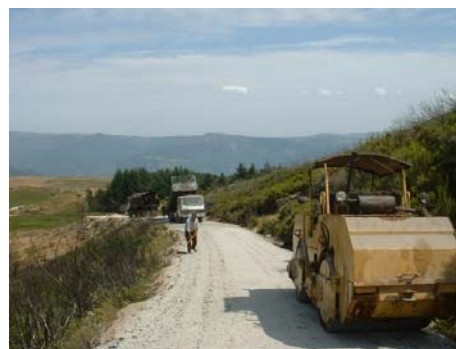
Conclusão da pavimentação em alcatrão do caminho entre o Vilar e o cruzamento da Lameira (Uz) – Vilar de Cunhas
