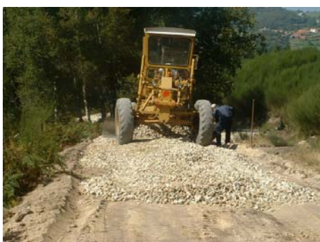
Continuação da pavimentação do caminho desde Magusteiro a Juguelhe - Riodouro
