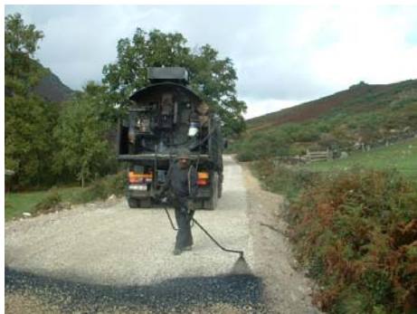
Continuação da pavimentação em alcatrão do caminho entre Porto D'Olho e as Torrinheiras - Abadim
