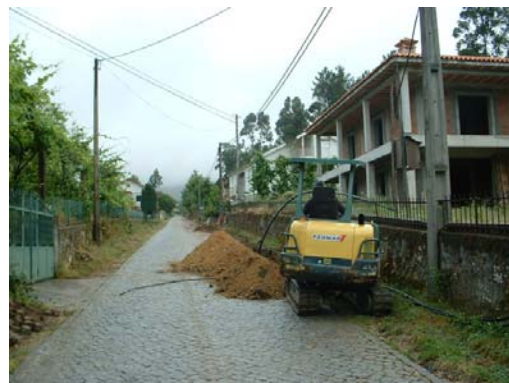
Continuação da ampliação e reformulação do sistema de abastecimento de água em Bucos
