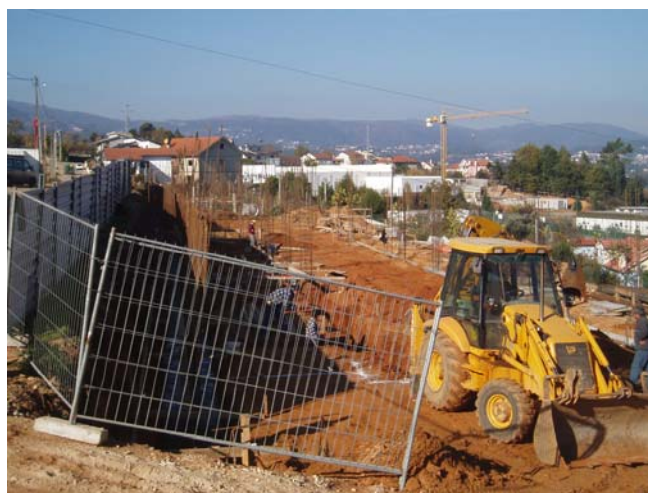
Continuação das obras da habitação social no Arco de Baúlhe
