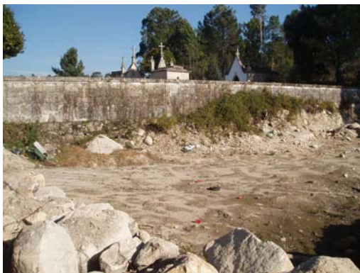
Continuação das obras de ampliação do Cemitério de Pedraça
