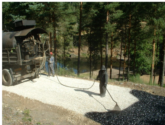
Continuação da pavimentação em alcatrão do caminho de ligação entre a freguesia de Gondiaes e o concelho de Boticas (Apoio da Junta de Freguesia)
