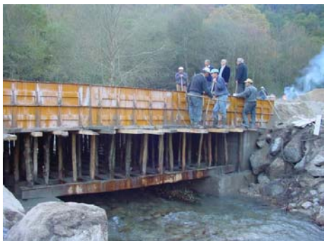
Construção de pontão que ligará o caminho das Fontainhas (Passos) ao limite do Concelho – Pavimentação dos acessos
