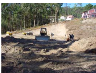
Construção do Polidesportivo de Outeiro
