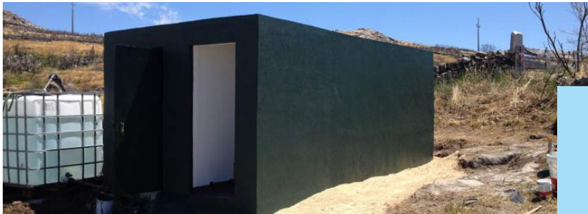
Beneficiação do reservatório de abastecimento de água de Juguelhe
