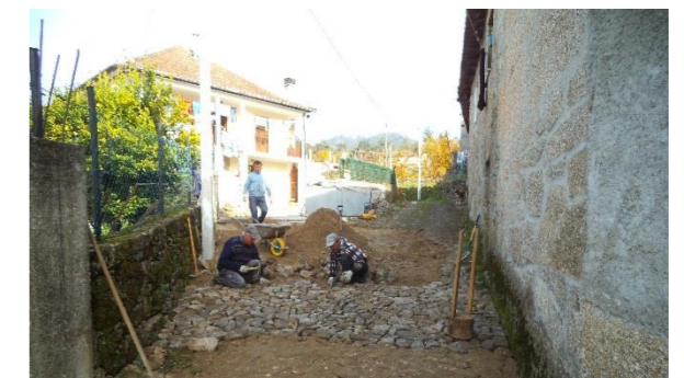
Repavimentação de caminho, no lugar de Chacim, em Refojos
