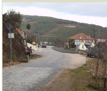
Limpeza de bermas e valetas, em Gondiaães
