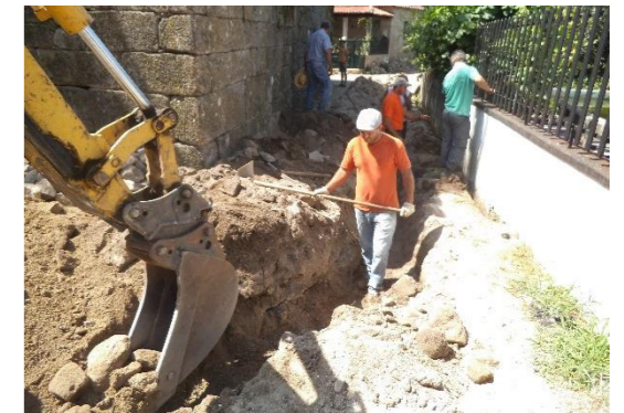
Execução de rede de esgotos, no Lugar de Chacim, em Refojos
