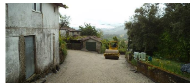
Repavimentação em alcatrão da Rua António Maria Rebelo, em Cabeceiras de Basto
