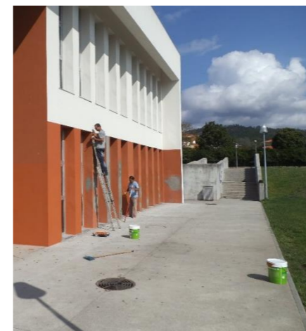
Reparação de paredes exteriores na Escola Básica e Secundária de Cabeceiras de Basto
