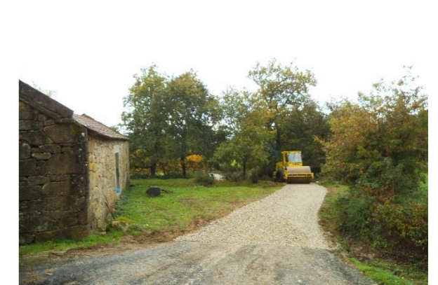
Pavimentação do Caminho da Poça da Fraga, no lugar de Vila Boa, em Bucos
