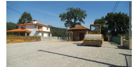
Pavimentação em alcatrão do Largo da Capela de Sto. António, em Basto
