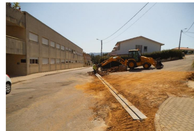
Colocação de canaletas e dreno na Rua do Souto, no Arco de Baúlhe
