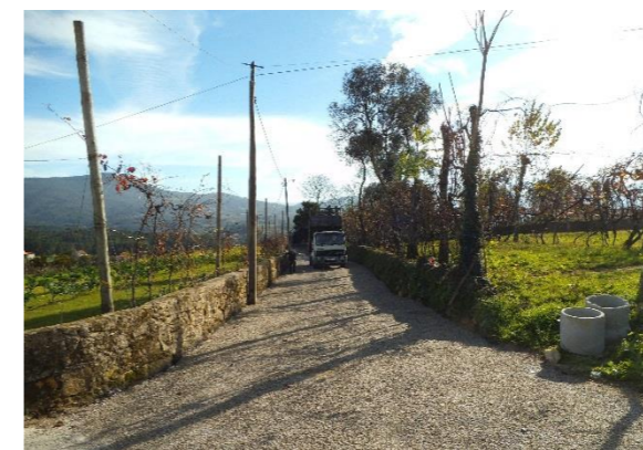
Repavimentação da Travessa da Malga, em Cavez
