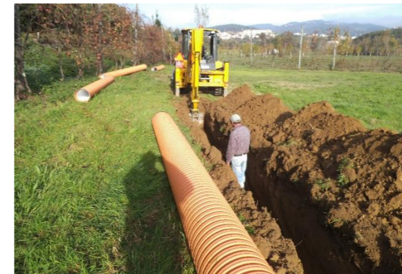
Execução de conduta de águas pluviais no Caminho da Carvalhosa, no lugar de Paçô, em Refojos
