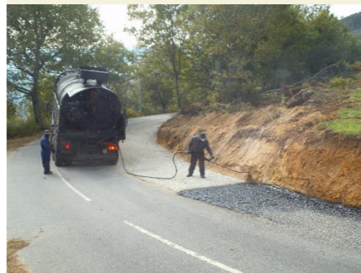
Pavimentação do alargamento de curva na estrada para Cabezeiras, em Riódouro
