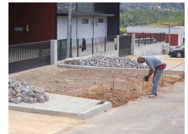
Pavimentação de passeios e zonas de estacionamento no Parque Industrial de Vila Nune
