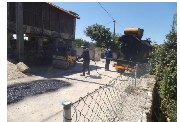
Repavimentação em alcatrão da Quelha do Figueiredo, em Abadim
