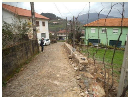
Execução de muro na Rua do Terreiro, na Faia
