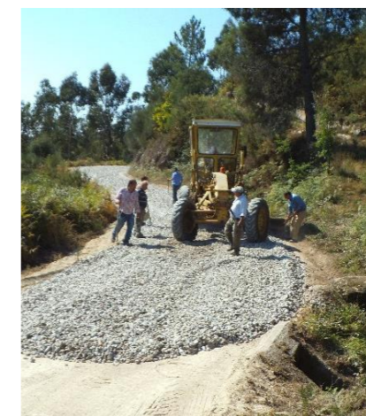
Pavimentação em alcatrão do Caminho de Lapela, em Cabeceiras de Basto
