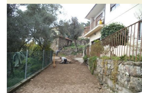
Repavimentação do Caminho de Buenos Aires, em Pedraça
