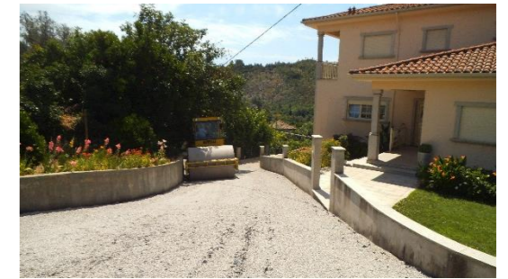
Repavimentação em alcatrão do Caminho de Reiros, em Alvite
