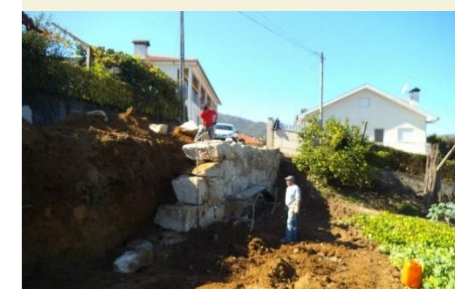
Execução de muro no lugar de Paçõ, em Alvite
