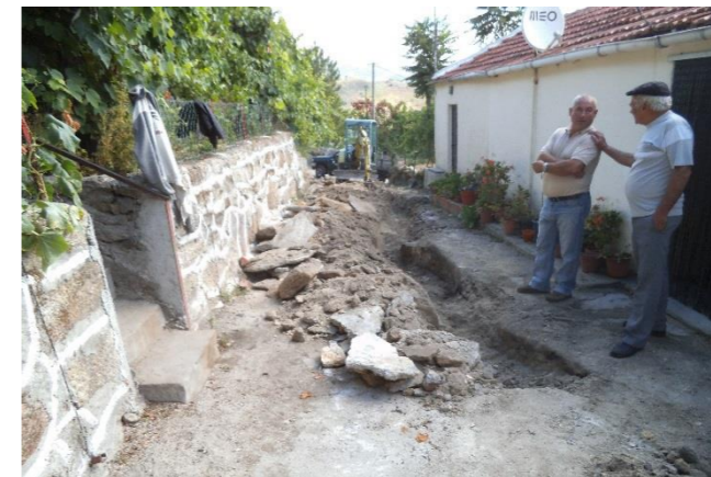
Ampliação de rede de saneamento, no lugar de Palheiros, em Cavez
