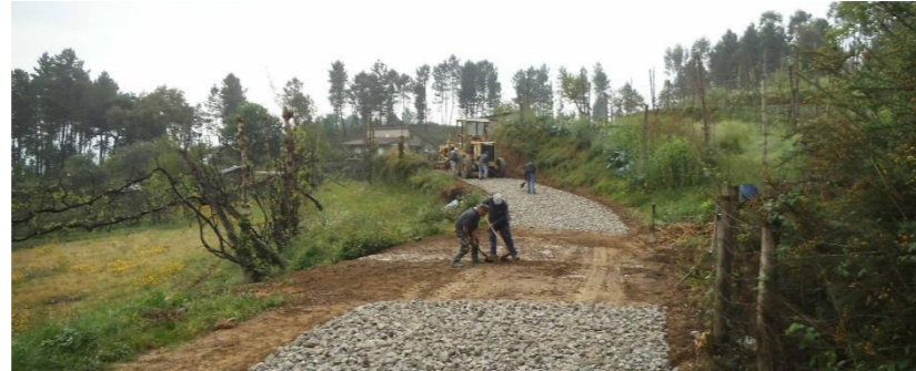
Pavimentação em alcatrão do Caminho da Bouça, na Faia, para o Vilar, no Arco de Baúlhe
