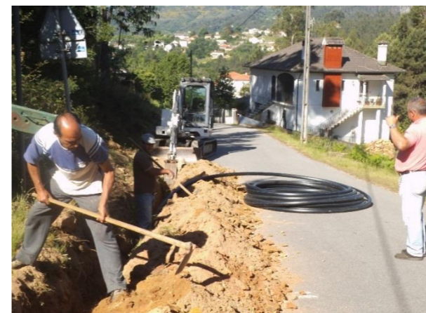
Substituição de conduta de água na Rua Padre Domingos Pereira, Raposeira, em Refojos
