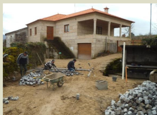
Pavimentação da Rua da Trofa, em Cavez
