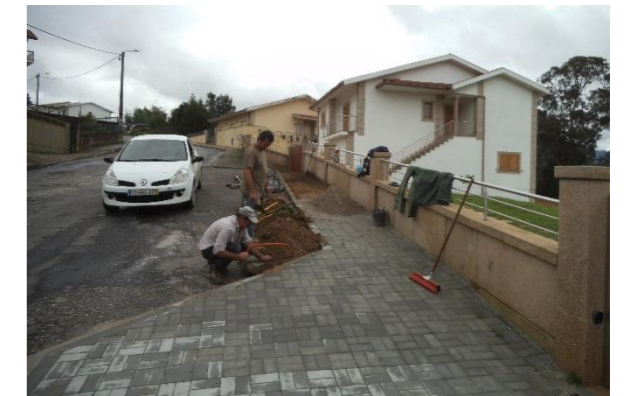
Execução de passeio no Loteamento do Viso, em Pedraça
