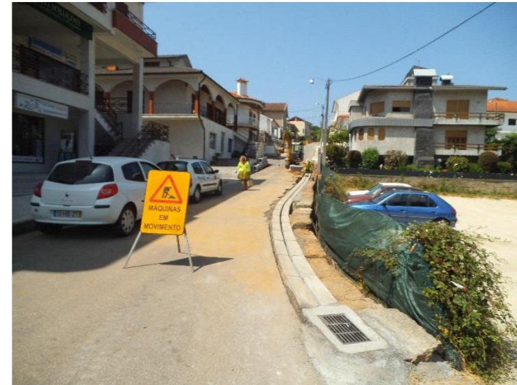
Colocação de canaletas na Rua da Quintã, no Arco de Baúlhe
