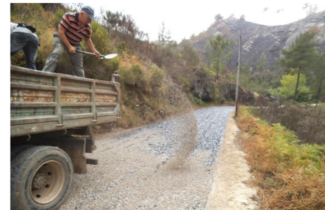
Repavimentação em alcatrão de caminho de acesso ao lugar de Celeirô do Monte, em Cabeceiras de Basto
