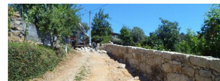
Alargamento do Caminho do Tarrado à Mua, em Pedraça
