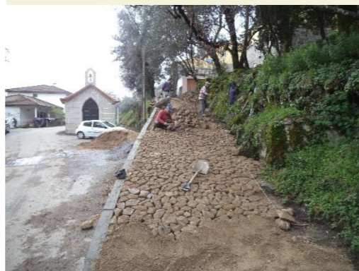
Pavimentação de caminho no lugar da Reboriça, em Cavez
