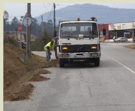
Limpeza de bermas e valetas da EN 311, em Refojos
