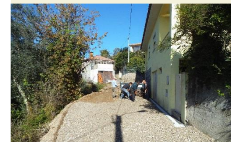
Pavimentação do Caminho da Sobreira, em Outeiro
