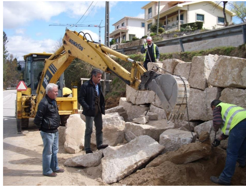
Construção de muro na EN 311, no lugar da Cancela, em Refojos
