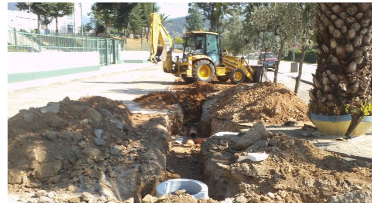
Colocação de drenos e conduta de águas pluviais no Parque de estacionamento na Escola Básica do Arco de Baúlhe
