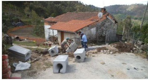
Colocação de canaletas no alto do lugar da Tarímbola, em Basto
