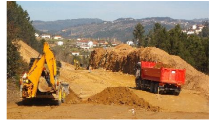
Construção da Variante EN205 entre Lameiros e a sede do Concelho.
