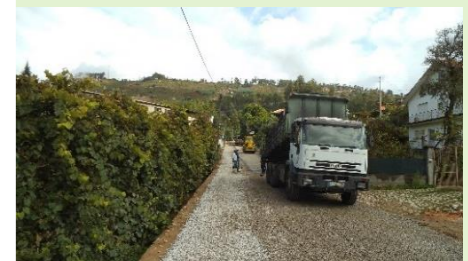
Pavimentação da estrada entre a Ponte da Ranha e a Zona Industrial, Abadim
