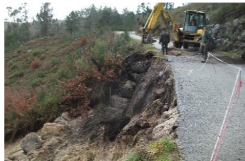
Execução de muro de suporte da estrada de Celeirô do Monte, Cabeceiras de Basto (S. Nicolau)
