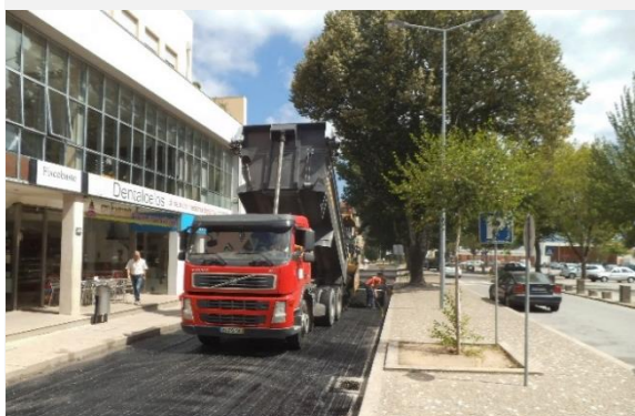
Pavimentação da Rua Antunes Basto, no Campo do Seco
