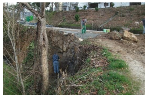
Execução de muro de suporte no Caminho de Reiros, Alvite
