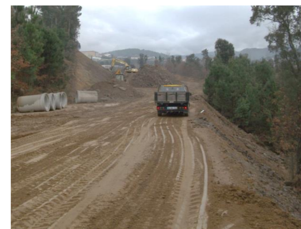
Construção da Variante EN205 entre Lameiros e a sede do Concelho
