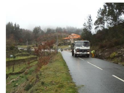
Limpeza de bermas, valetas e aquedutos entre a Quinta da Mata (Refojos) e Cavez
