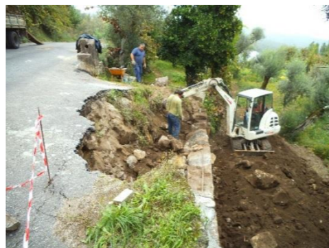
Reconstrução de muro de suporte do caminho do fundo do lugar de Moimenta, Cavez
