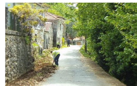
Limpeza de bermas e valetas no Caminho do Queiroal, Cabeceiras de Basto (S.Nicolau)
