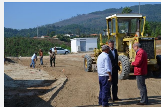
Pavimentação de arruamento na Zona Industrial de Vila Nune
