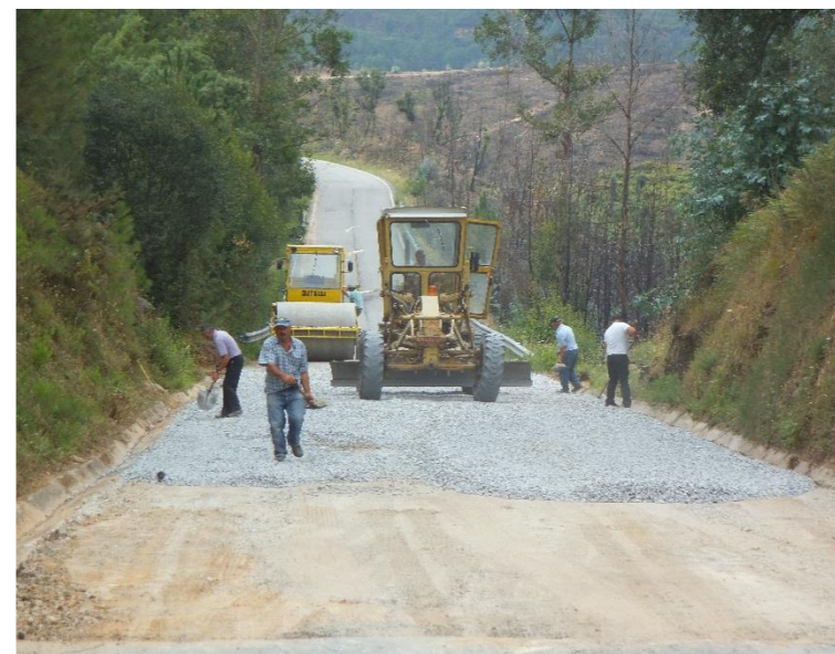
Repavimentação de troço da estrada entre Parada e a Ponte da Barca sobre o rio Tâmega
