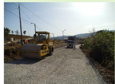
Pavimentação de troço da antiga EN 205 na Devesa, Basto
