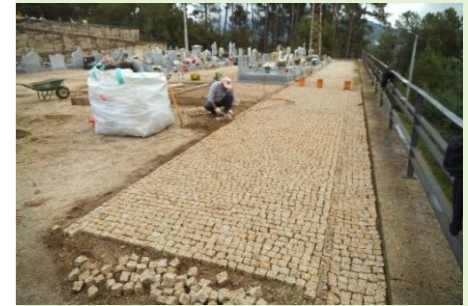
Pavimentação de caminhos no Cemitério de Refojos
