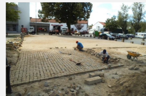
Pavimentação da área do antigo Parque Infantil no Campo do Seco
