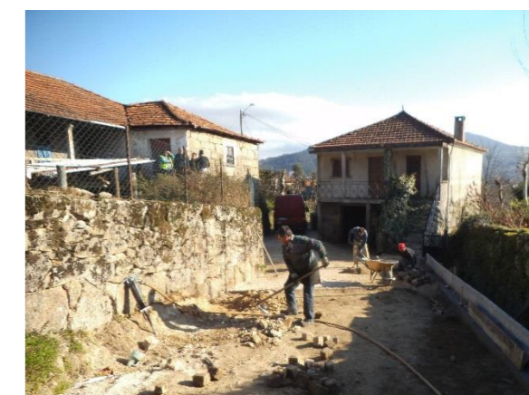
Pavimentação da Rua da Trofa, Cavez
