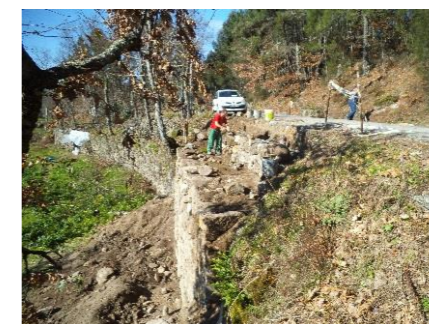
Reconstrução de muro Moimenta – Cavez
