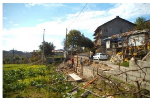
Construção de muro de suporte da estrada no centro de Petimão, Alvite
