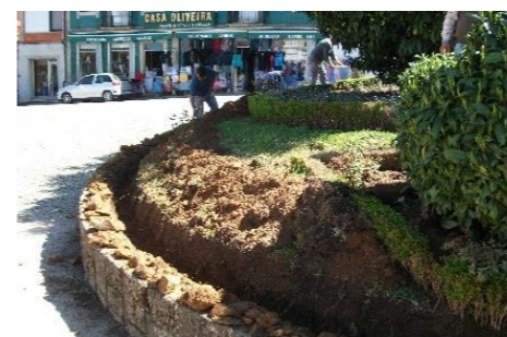
Execução de rede de rega no jardim do Nó Viário no Arco de Baúlhe
