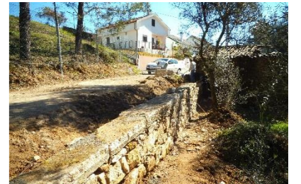
Construção de muro de suporte na Rua do Alto do Monte.
