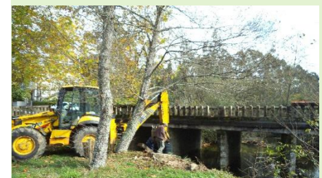
Reparação de Ponte em Souto Mouro, Bucos
