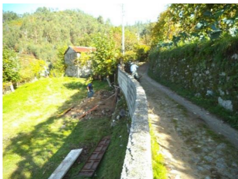
Reconstrução de muro de suporte de caminho no lugar de Lameirinhas, Cabeceiras de Basto (S. Nicolau)
