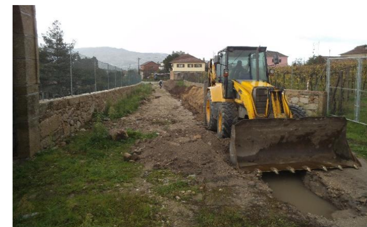
Construção de infraestruturas básicas na nova Rua do Pedral, Cavez
