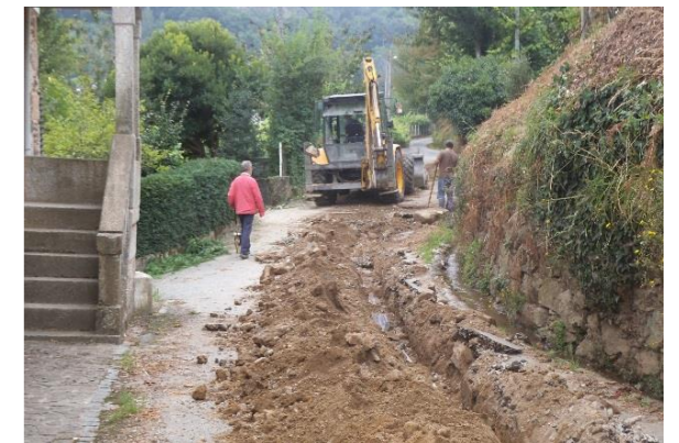
Substituição de conduta de água no caminho da Escola para a Bouça na freguesia da Faia.
