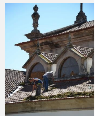
Limpeza do telhado do Mosteiro de S. Miguel de Refojos
