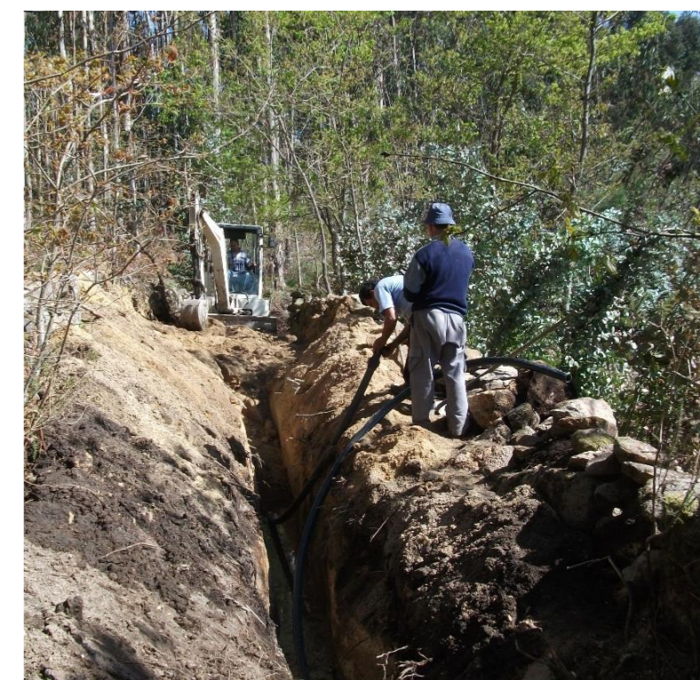
Substituição da conduta de água para depósito de Leiradas, Riodouro
