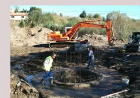
Nova captação para reforço do abastecimento de água na Cumieira, Cabeceiras de Basto
