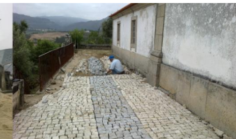
pavimentação em cubo do adro da igreja de Pedraça
