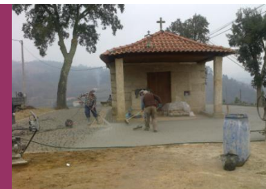
pavimentação em cubos da envolvente da Capela de Sto. António, Basto
