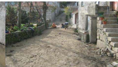
beneficiação em calçada junto à Capela de Celeirô do Monte na freguesia de Cabeceiras de Basto (S. Nicolau)
