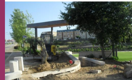
construção de acesso ao palco no Parque do Mosteiro
