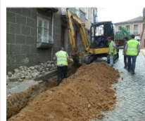
desativaram-se 4 fossas sépticas e entraram em funcionamento 3 estações elevatórias
