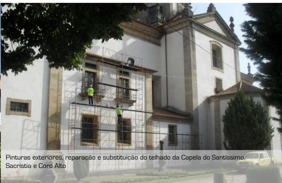
Pinturas exteriores, reparação e substituição do telhado da Capela do Santíssimo, Sacristia e Coro Alto
