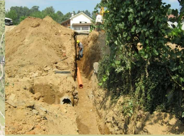
Execução de infra-estruturas na Variante Sul, Lamas - Sobreira
