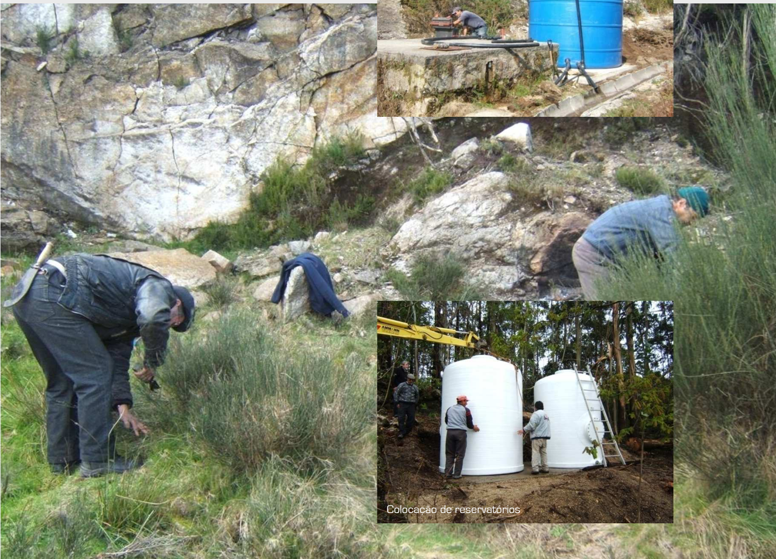
Limpeza de captação de água, Vilela, Riodouro
