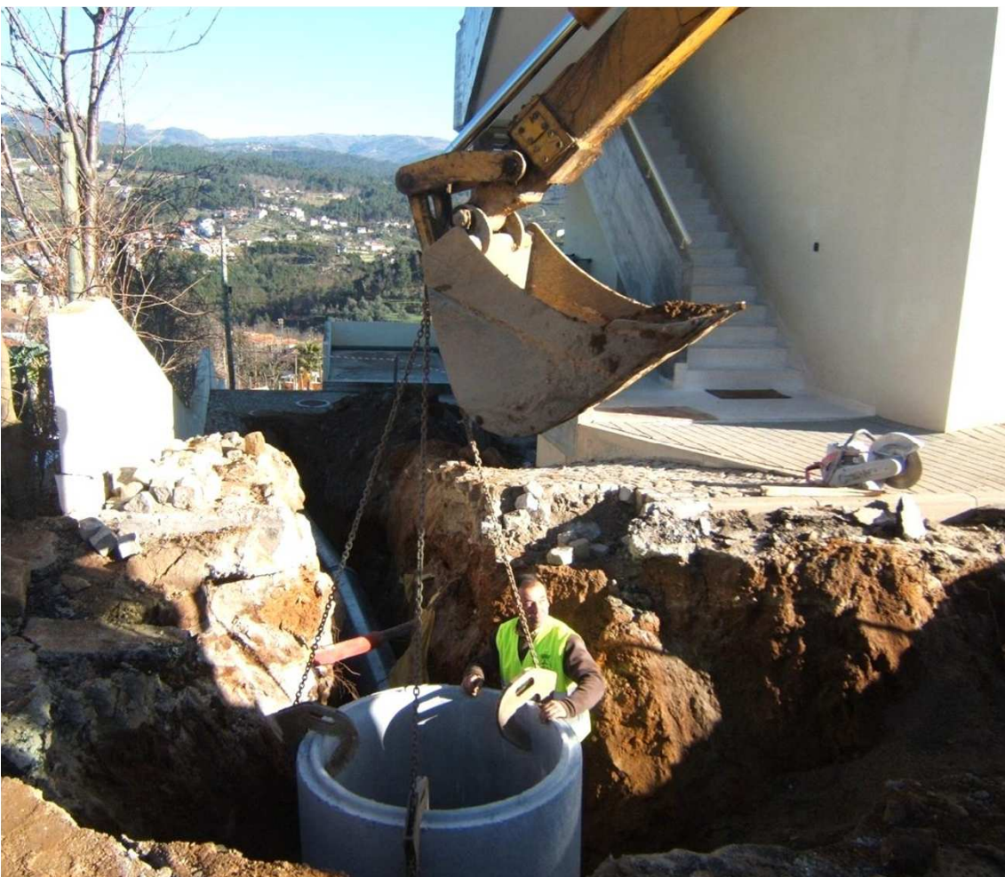
Desvio de águas pluviais junto ao edifício de Habitação Social - Rua do Souto, Arco de Baúlhe
