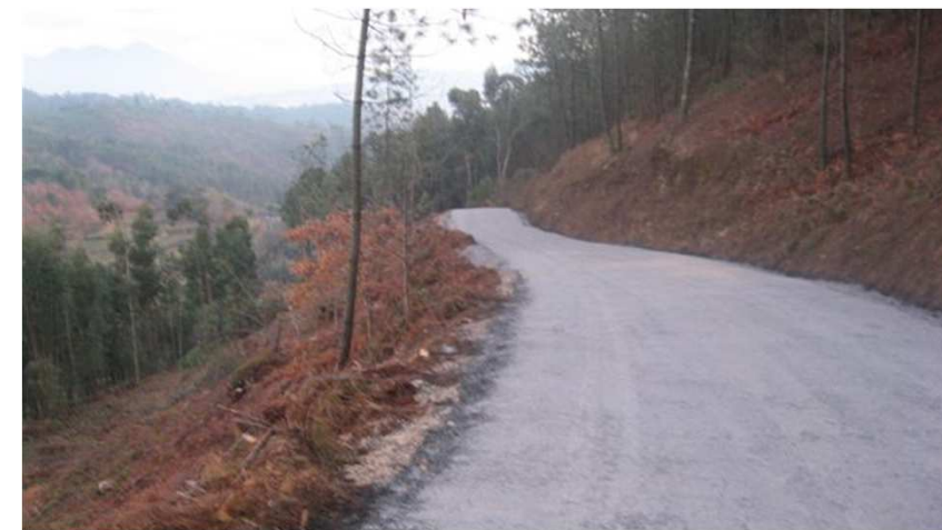
Pavimentação do caminho de Fontão, Refojos de Basto
