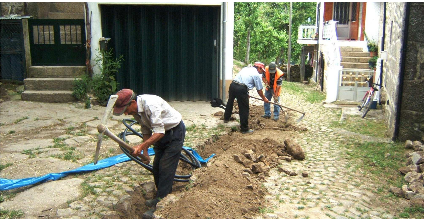
Construção de conduta de abastecimento de água em Bucos
