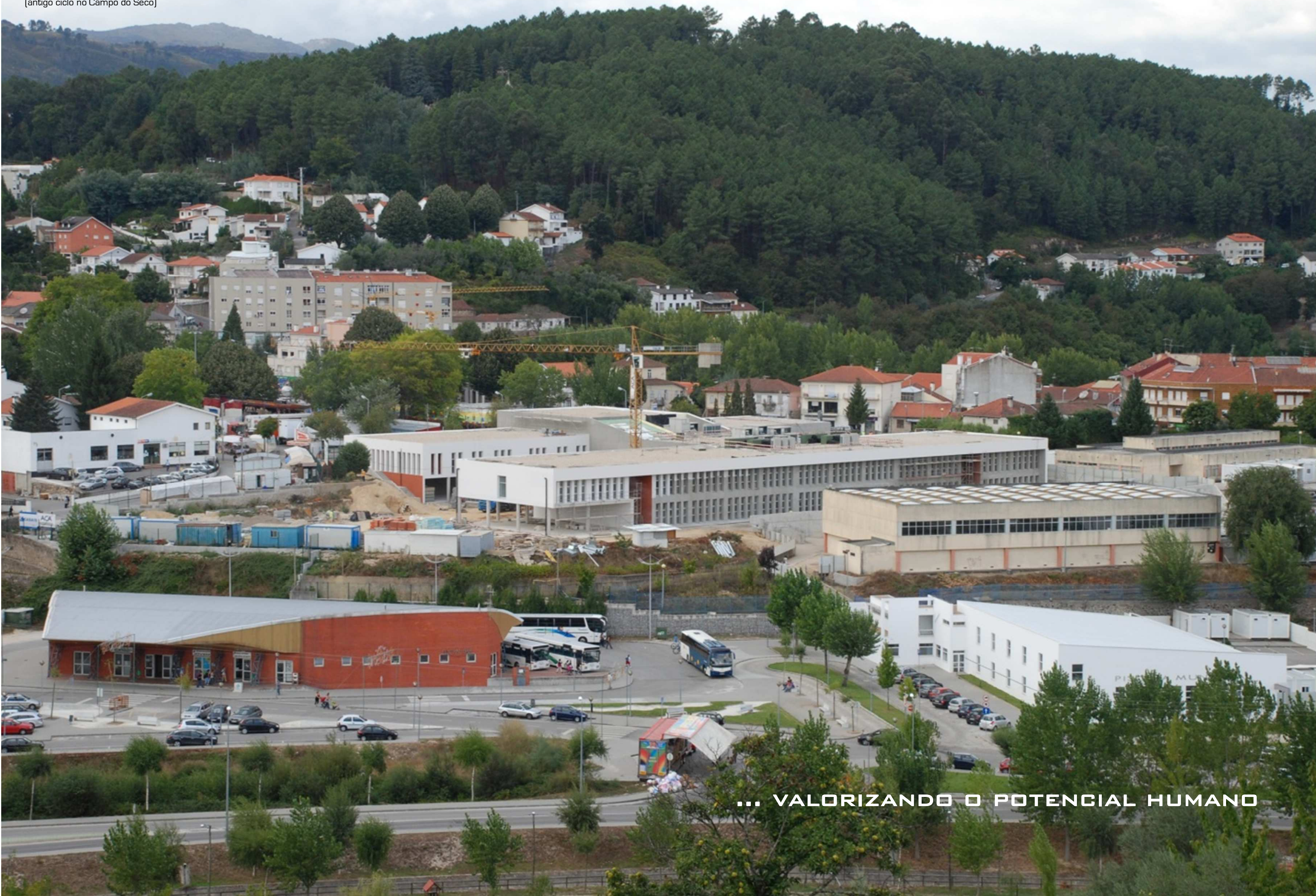
Escola Básica e Secundária de Refojos de Basto, em execução – vista geral (antigo ciclo no Campo do Seco)
