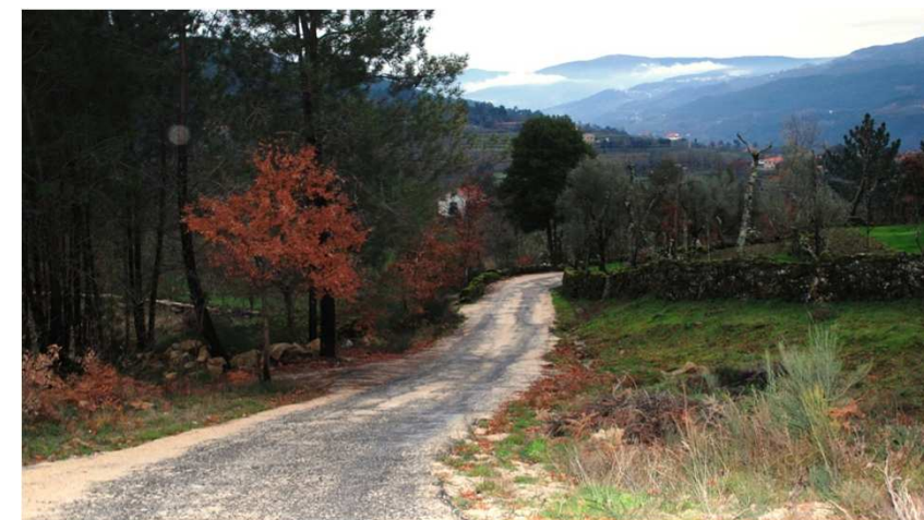
Rompimento e pavimentação da estrada de Moimenta, Cavez a Vilela, Riodouro
