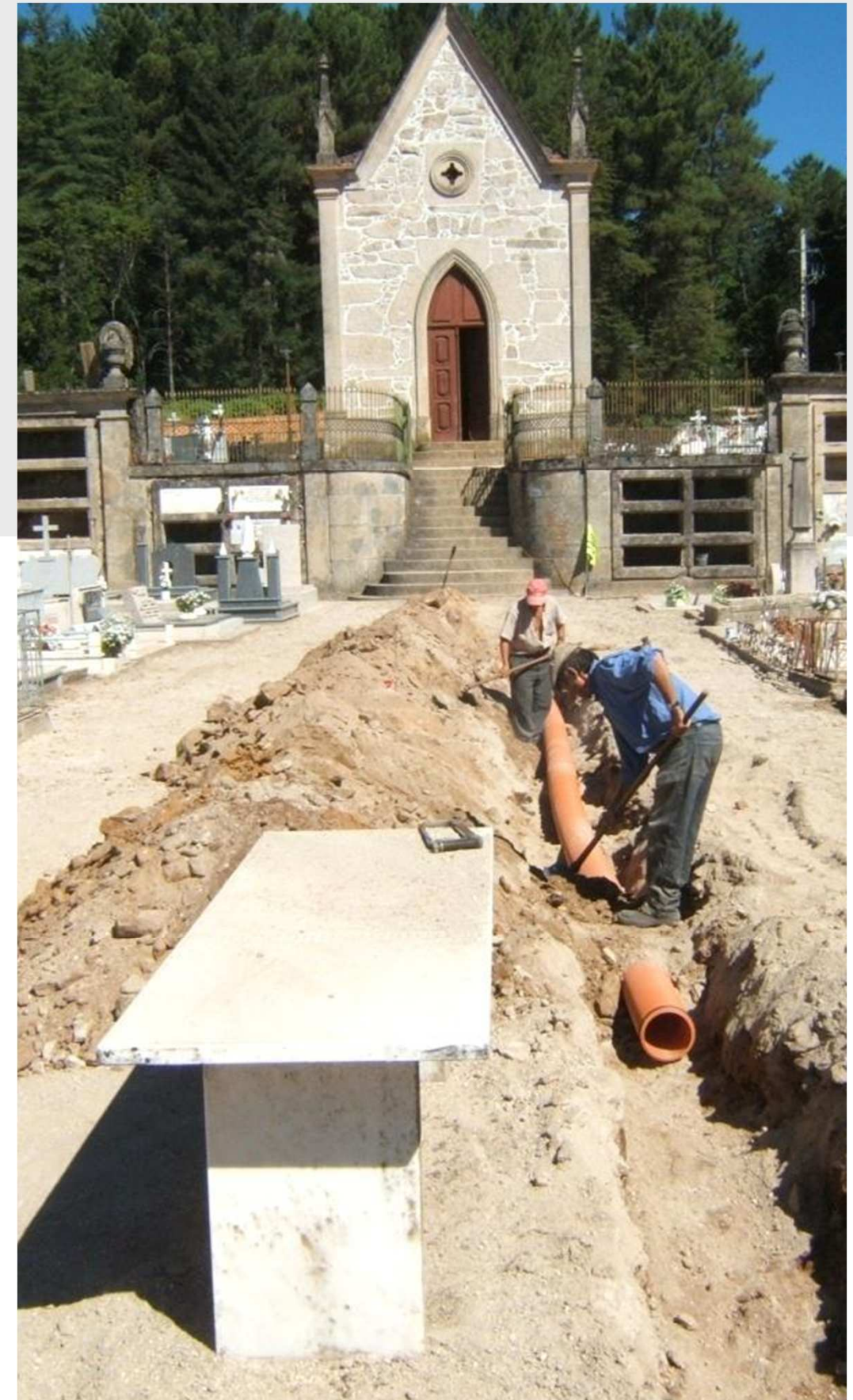
Execução de rede de drenagem de águas pluviais no arruamento central do Cemitério de Refojos
