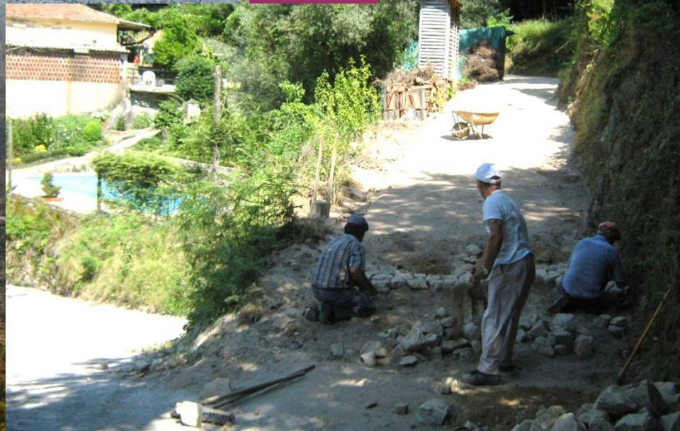
Repavimentação em calçada de caminho em Água Redonda, Refojos
