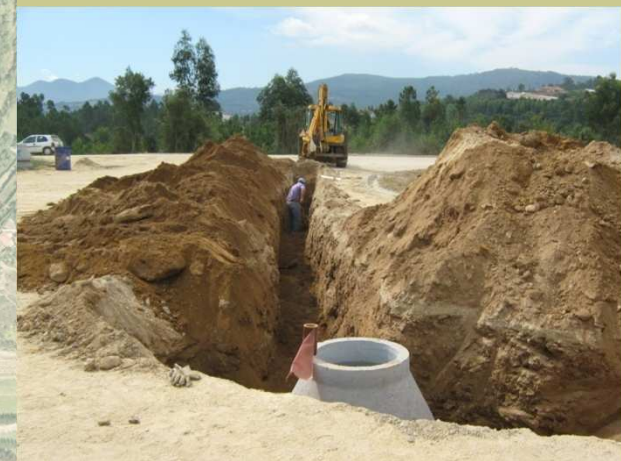
Execução de Rede de Drenagem de Esgotos na Variante Sul, Lamas - Sobreira
