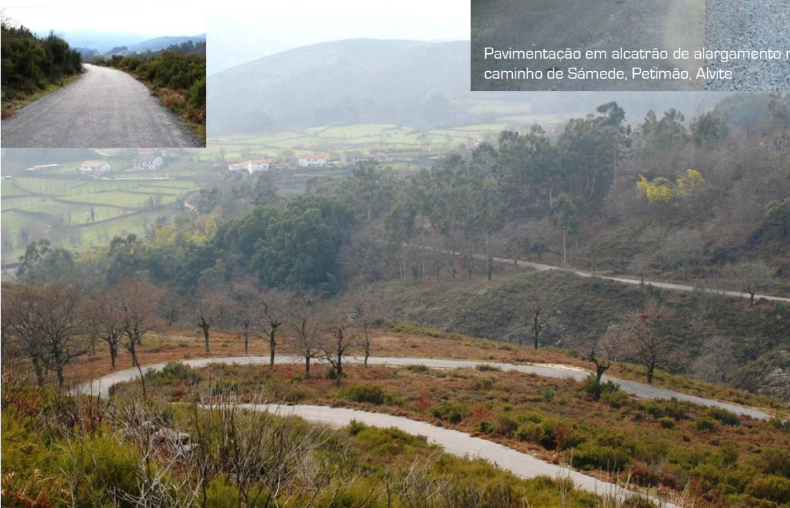
Pavimentação em alcatrão de estrada de ligação de Vila Boa à Veiga, Bucos
