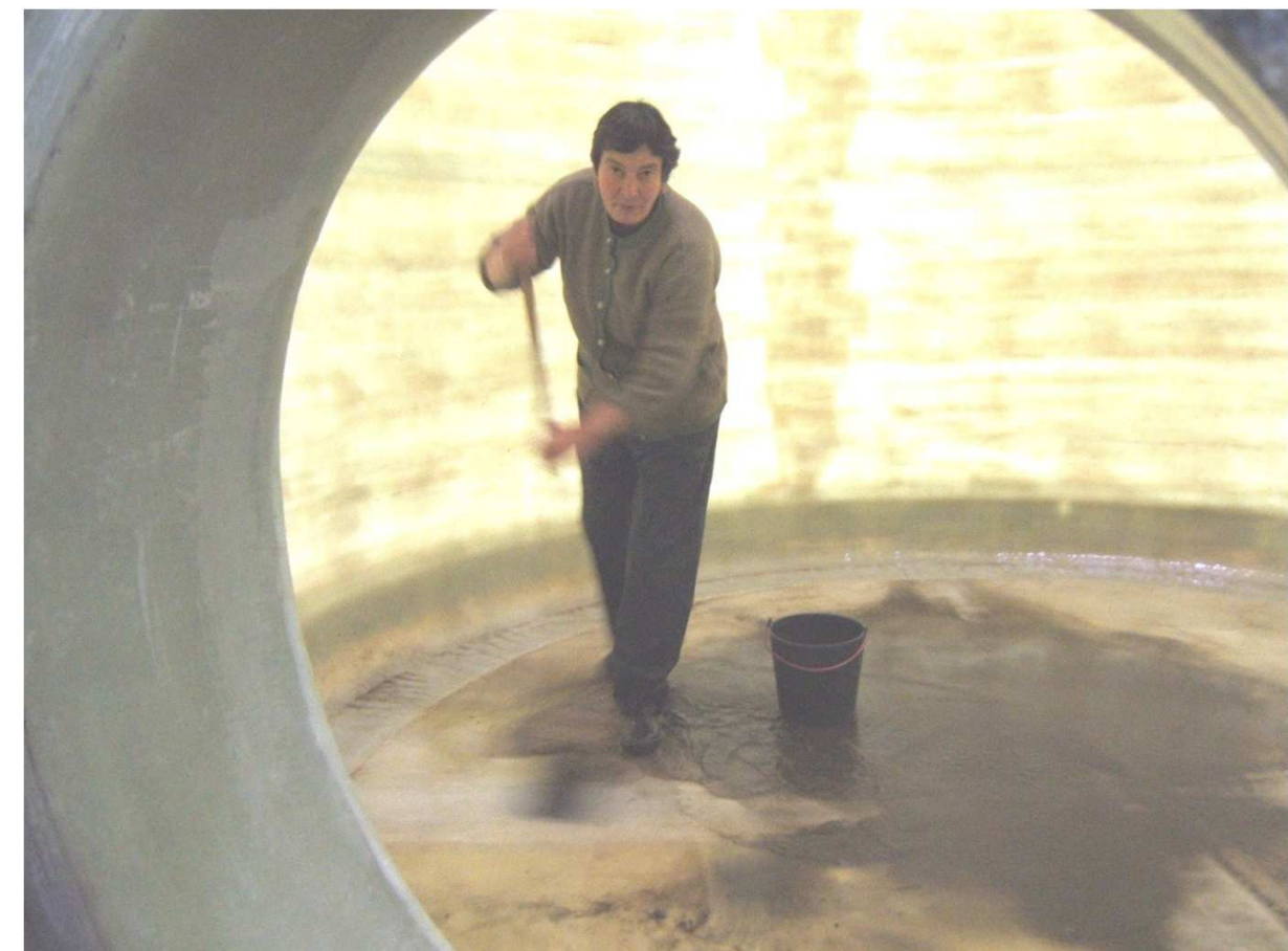
Limpeza de reservatório
