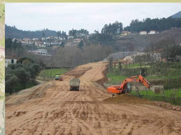
Rompimento da Variante Sul, Lamas - Sobreira
