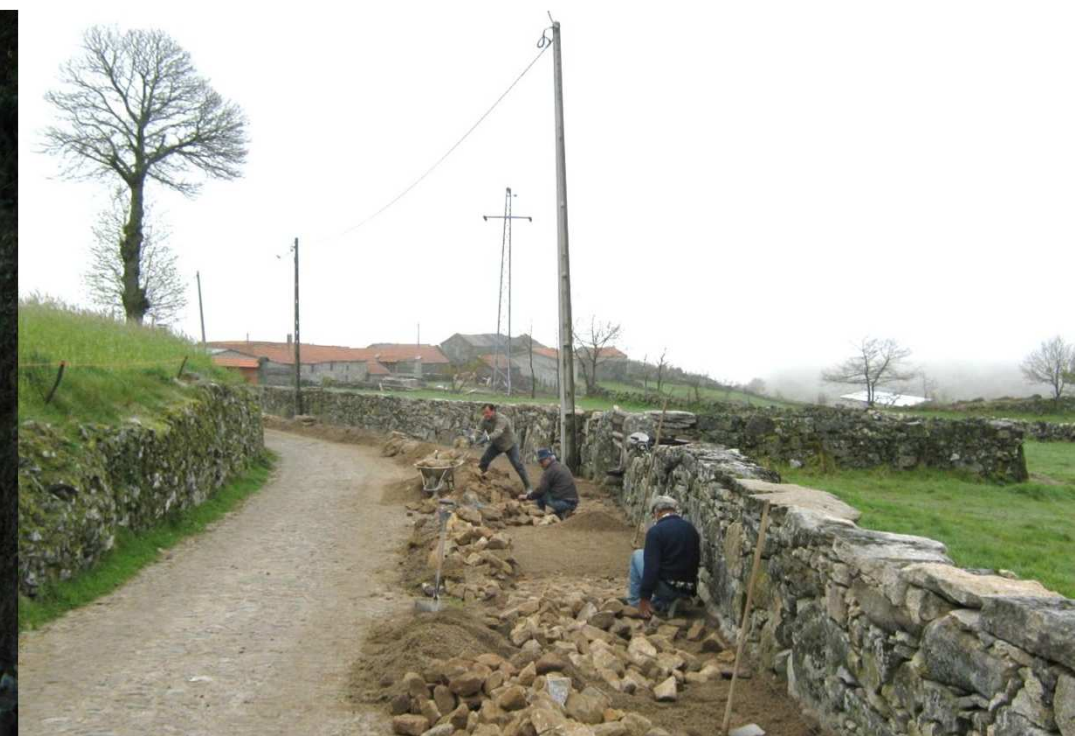
Pavimentação em calçada de alargamentos no centro da Uz, Vilar de Cunhas
