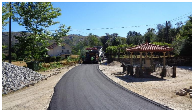
Repavimentação da Estrada Municipal 526 em Bucos
