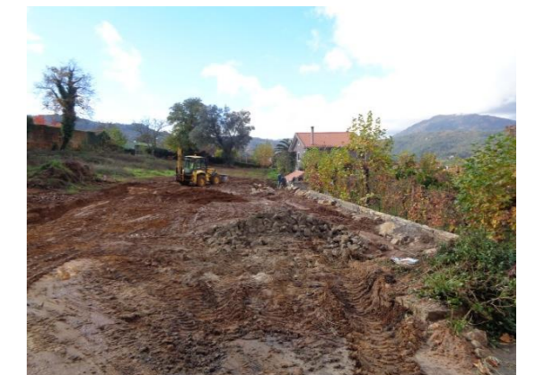
Construção de muro e rompimento da Rua do Alto do Mirante, Arco de Baúlhe
