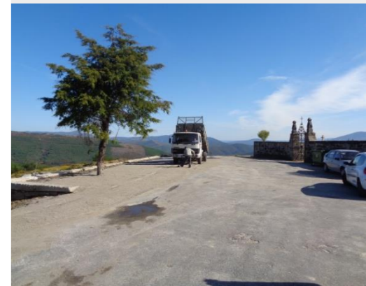
Pavimentação de Caminho junto ao cemitério do Vilar, Vilar de Cunhas
