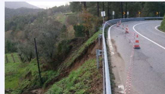
Derrocada na EN 210, Vila Nune
