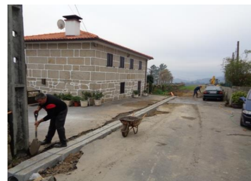
Colocação de canaletas na Portela Grande, Boadela, Pedraça
