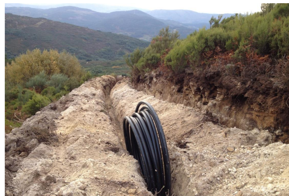
Construção de nova conduta adutora de água em Moimenta, Cavez
