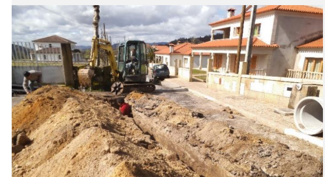
Ampliação da rede de saneamento na Rua do Fojo Velho, Cavez
