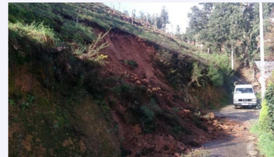
Deslizamento na Rua do Paiol, Vila Nune
