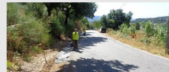
Construção de valetas na estrada entre Viso - Muro, Pedraça
