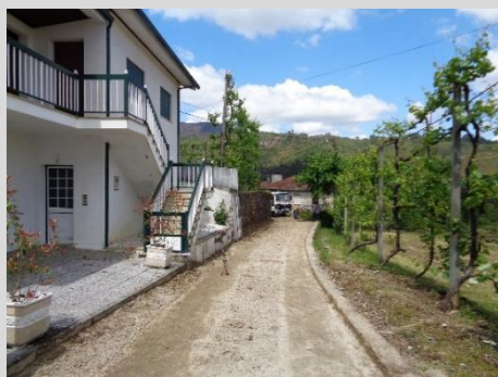
Repavimentação da Rua de Carcavelos, Basto
