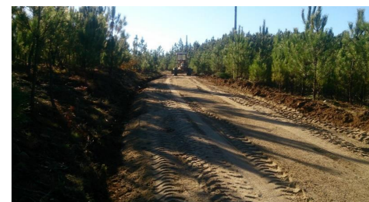
Regularização de caminho de acesso ao campo de treinos dos Bombeiros, Chacim, Refojos
