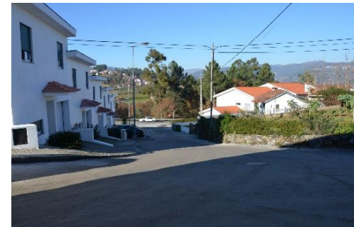
Repavimentação de vários arruamentos na Senra, Refojos
