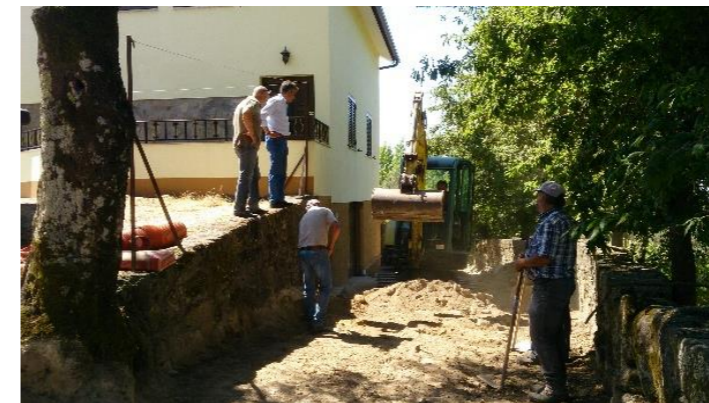
Execução de rede de saneamento na Portela do Fojo, Moimenta, Cavez
