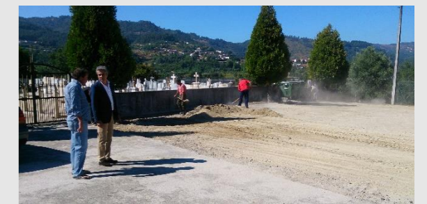
Pavimentação do Largo do Cemitério de Basto
