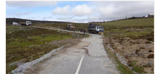
Repavimentação da Variante da Uz, Vilar de Cunhas
