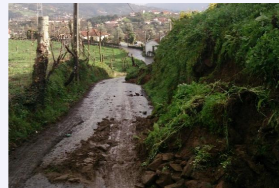
Deslizamento no Lugar Novo, Faia
