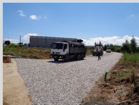
Pavimentação do arruamento da Zona Industrial de Lameiros
