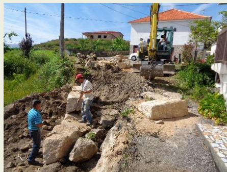
Reconstrução de muro na Rua da Atafona, Cavez
