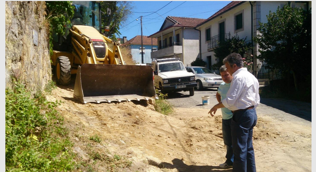
Ampliação da rede de saneamento na Calçada da Cumieira, Cabeceiras de Basto
