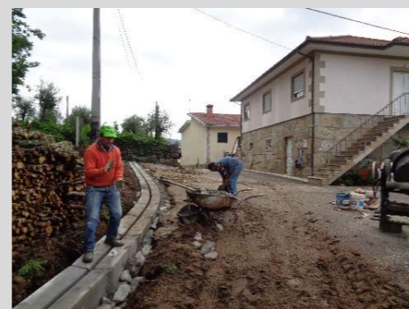
Colocação de canaletos no lugar de Senra, Refojos
