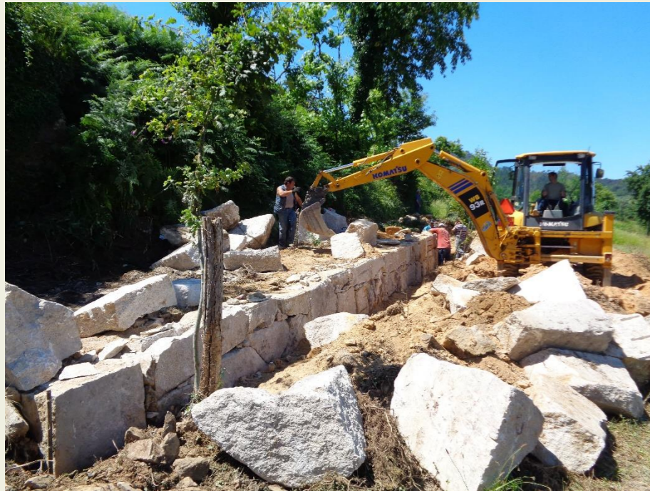
Construção de muro na Rua das Fontelas, Faia
