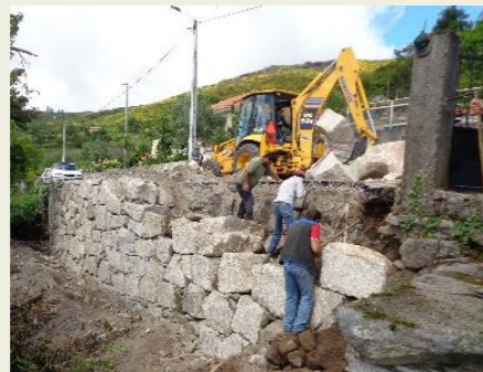
Construção de muro na estrada do Vilar para o Samão, Gondães e Vilar de Cunhas
