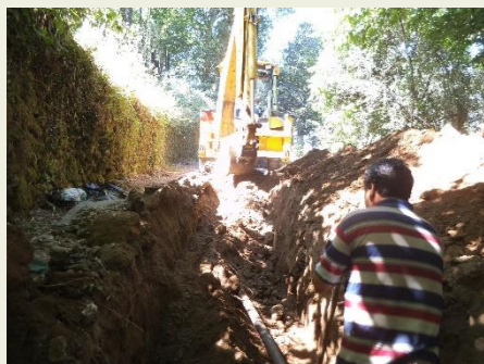
Ampliação da rede de águas pluviais e esgotos em Gragilde, Painzela
