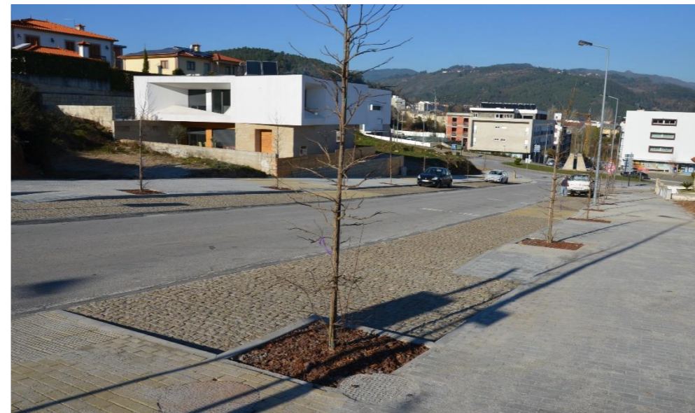
Requalificação urbanística da Avenida Capitães de Abril entre a Rotunda dos Combatentes e a Rua do Telhado
