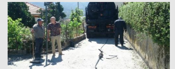
Pavimentação da Rua José Leite Magalhães, Vila Nune
