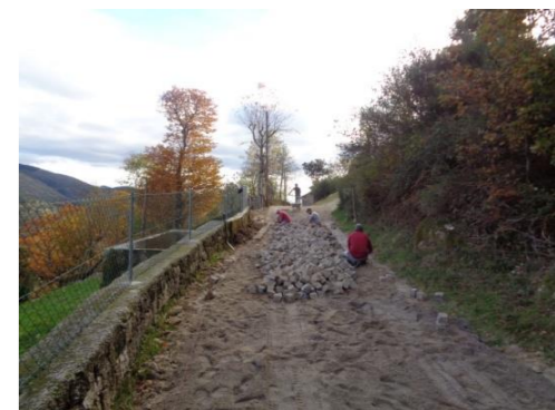
Pavimentação do Caminho do Alto de Teixugueiras, Riódouro
