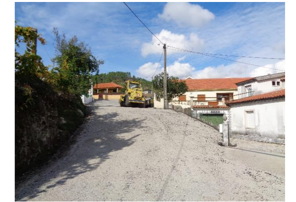
Repavimentação do Caminho da Fragata, Abadim
