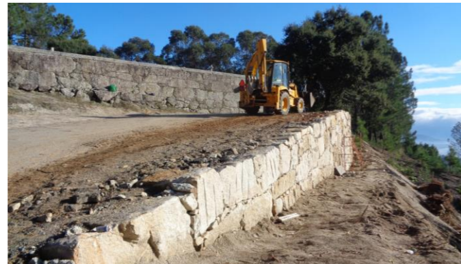
Construção de muro no largo do cemitério de Alvite
