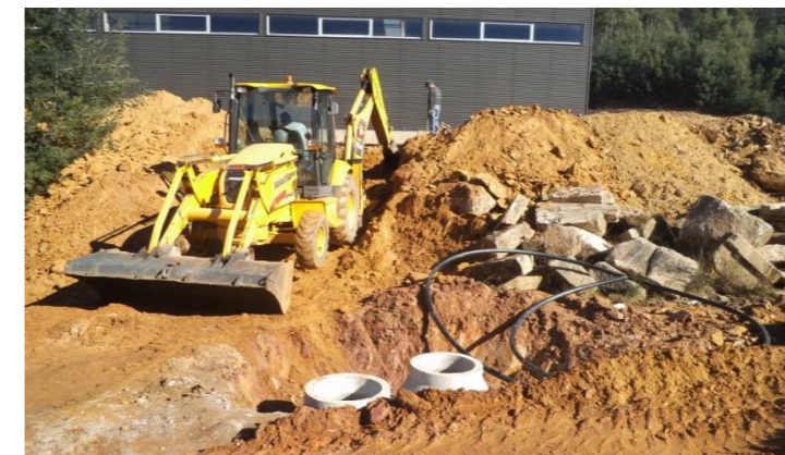
Construção de infraestruturas nas futuras oficinas municipais
