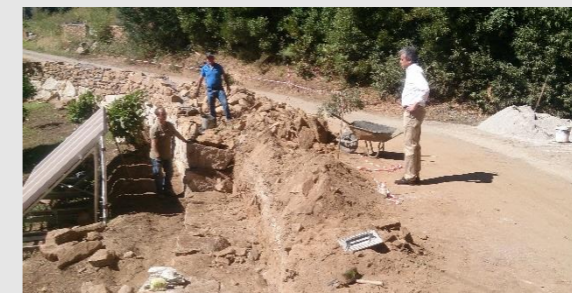
Construção de muro na Travessa de Vinha de Mouros, Refojos
