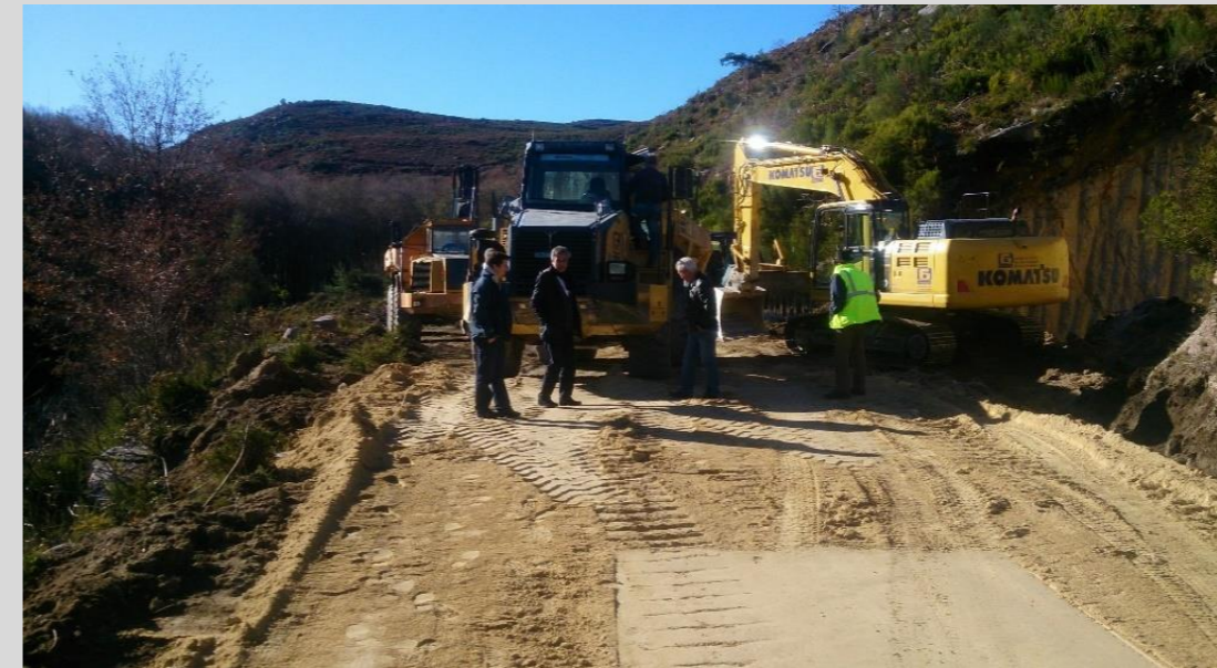
Obras de beneficiação do troço do Rali de Portugal na Serra da Cabreira, entre a Veiga e Busteliberne, que irá ter lugar no dia 20 de maio de 2017.
