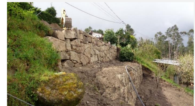
Construção de muro no Caminho de Tamonde, Arosa, Cavez
